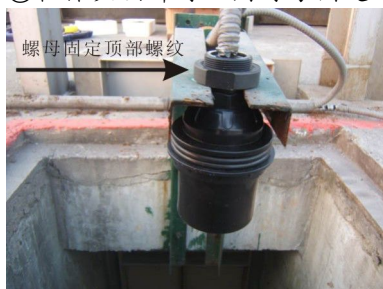
①在探头顶部螺纹用螺母固定
